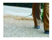
**7| Ausgleichen** - Nun das Kies oder den Splitt gleichmäßig verteilen. Nach Bedarf Kies nachfüllen, damit die Platten abgedeckt
