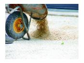
**6| Befüllen** - Mit Schubkarren oder Bagger. Wir empfehlen den Splitt oder Kies circa 2 cm über den Rand aufzufüllen, um langfristig 1 cm dicke Schicht über den Platten zu erhalten. (in den ersten Tagen verdichtet sich das Material) ->empfohlenes Füllmaterial 8-16 mm, unter http://www.werner-natursteine.com finden Sie sicher eine Steinart, die Ihnen gefaellt.
