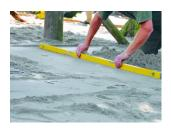
**3| Nivellierung** - Nun wird die feine Sand- oder Splittschicht aufgetragen. Diese ausgleichen und eine ebene Oberfläche schaffen
