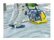
**2 | Verdichtung** - Das verdichtungsfähige Material (siehe oben) wird aufgetragen und verdichtet. Am besten mit einer Rüttelplatte (siehe links).
