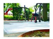
**4| Verlegung** - Die Platten werden lose auf den verdichteten und geglätteten Untergrund gelegt. Zur Stabilisierung ist das Geotextil überlappend und wird direkt unter der angrenzenden Platte angebracht.
