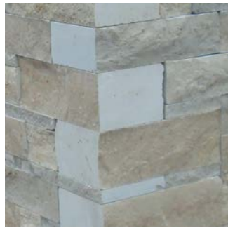
Mauerecke - Köpfe unbearbeitet
